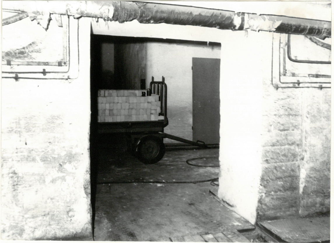
Bild 1 Haupttunnel unterhalb des Querbahnsteiges
