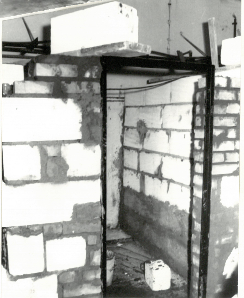
Bild 6 und 7 Bau des Ge- wahrstums
